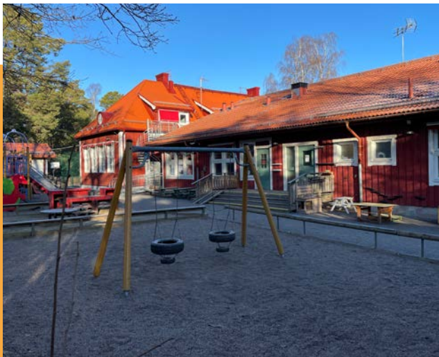
Muskö skola och förskola har renoverats. I detta ingick även upprustning av både skol- och förskolegård med bland annat ny lekutrustning, nytt staket/stängsel, konstgräs på en tidigare grusad aktivitetsplan och asfaltering av basketplan.
