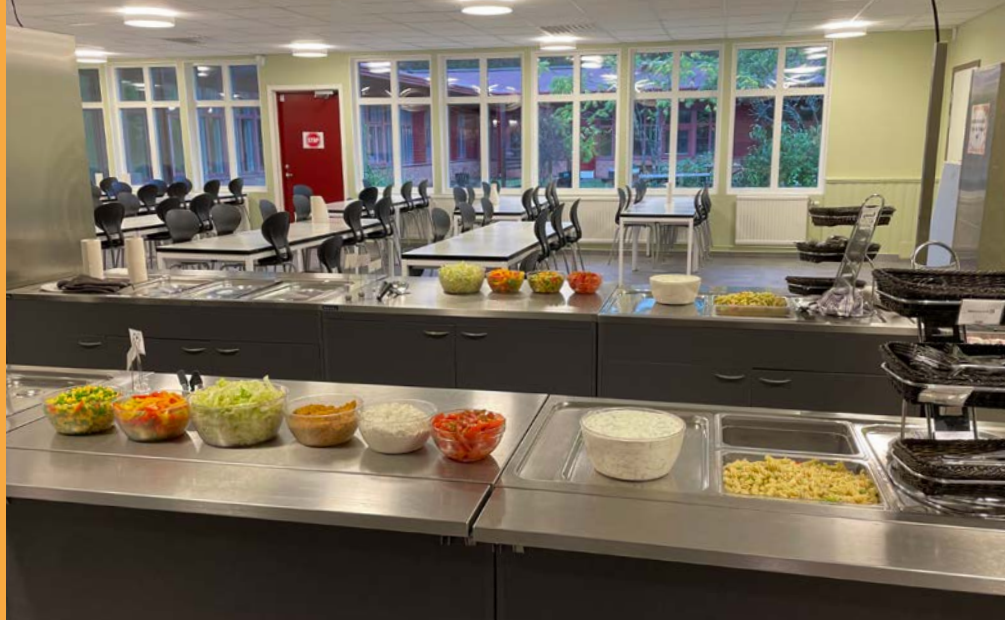
En totalrenovering av Kvarnbäcksskolan blev klar till höstterminen. Projektet innefattade bland annat renovering och ombyggnad av både matsal och kök.
