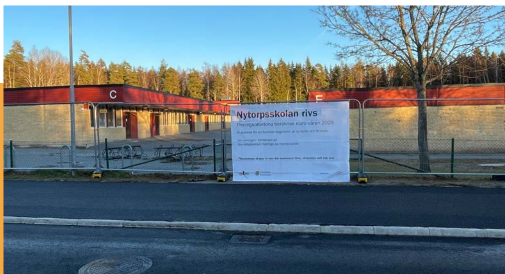
Under hösten genomfördes projektering för en rivning av Nytorpsskolan, exklusive skyddsrum, och i slutet av året startade rivningsarbetet.
