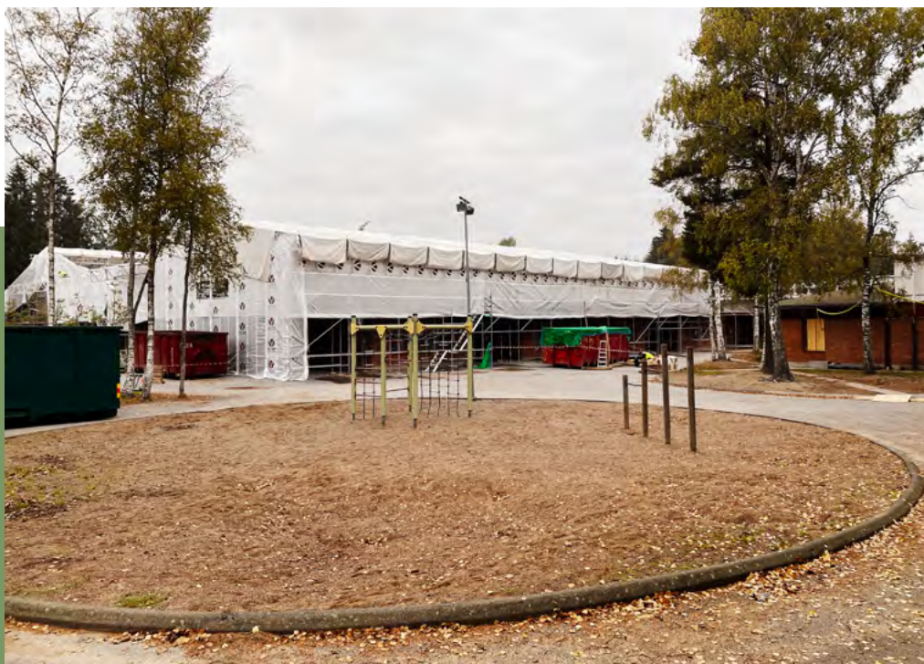
Kvarnbäcksskolan genomgår en totalrenovering under läsåret 2023/2024. Projektet innefattar renovering och ombyggnad av kök och matsal, ytskiktsrenovering, nya tekniska installationer i hela skolan samt nytt yttertak.
